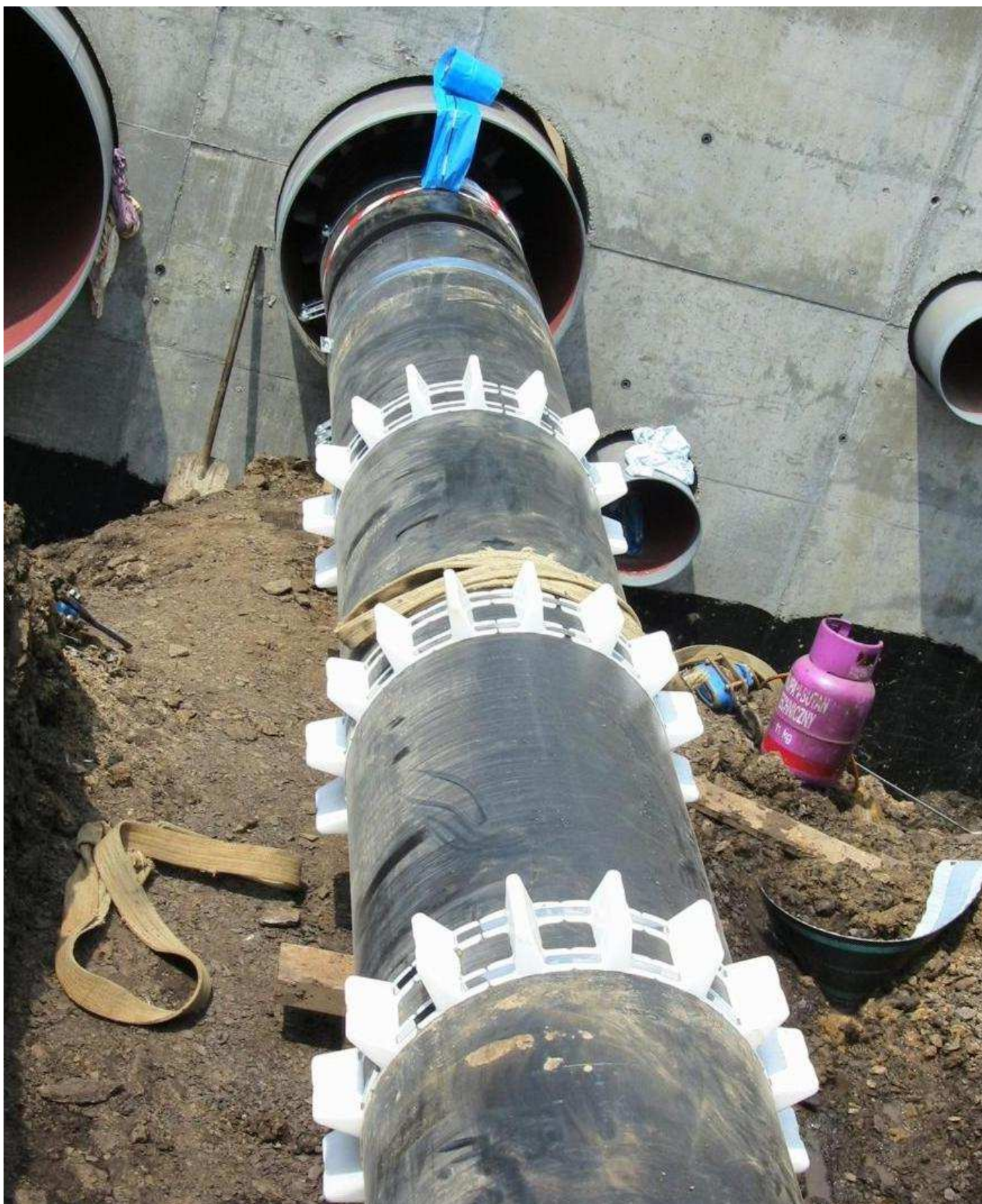
03 Objímky vodící - nasunutí potrubí s vodícími objímkami do chráničky
